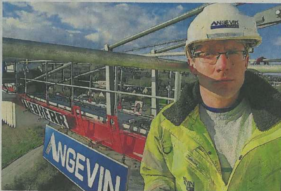
« Avec l'accord du conducteur de travaux de l'entreprise Angevin, Fabien Guernigou, je quitte la terre ferme direction 35 mètres au-dessus du sol en compagnie de Romain Crozon, le chef de chantier (ici en photo). »
