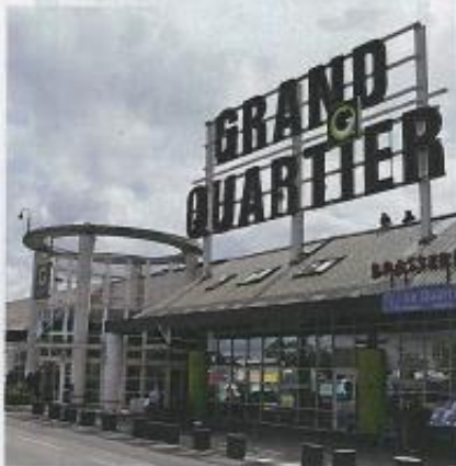
La façade du centre commercial va être entièrement revue
